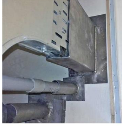
Loden mantels voor leiding- en kanaalendoorvoer
